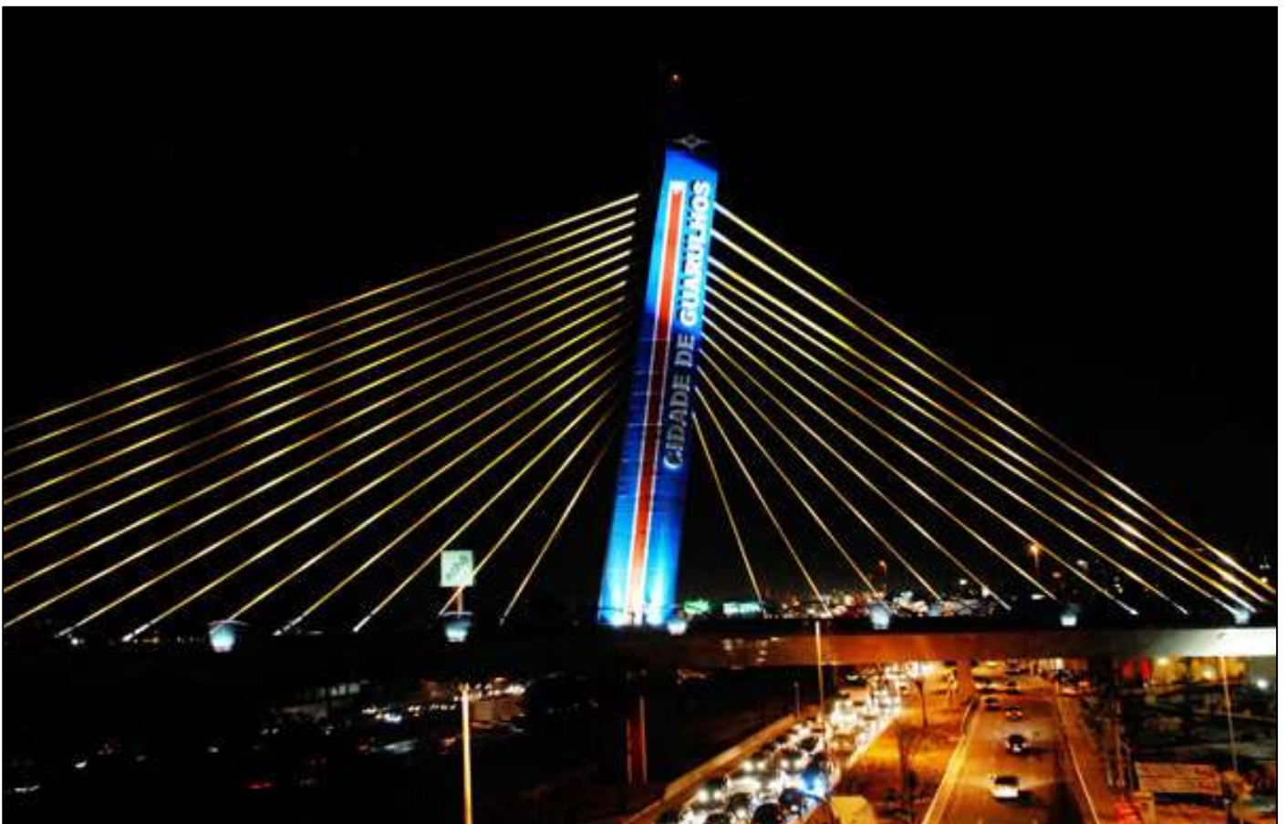
Viaduto Cidade de Guarulhos, Guarulhos - SP - Brasil, 2010.
