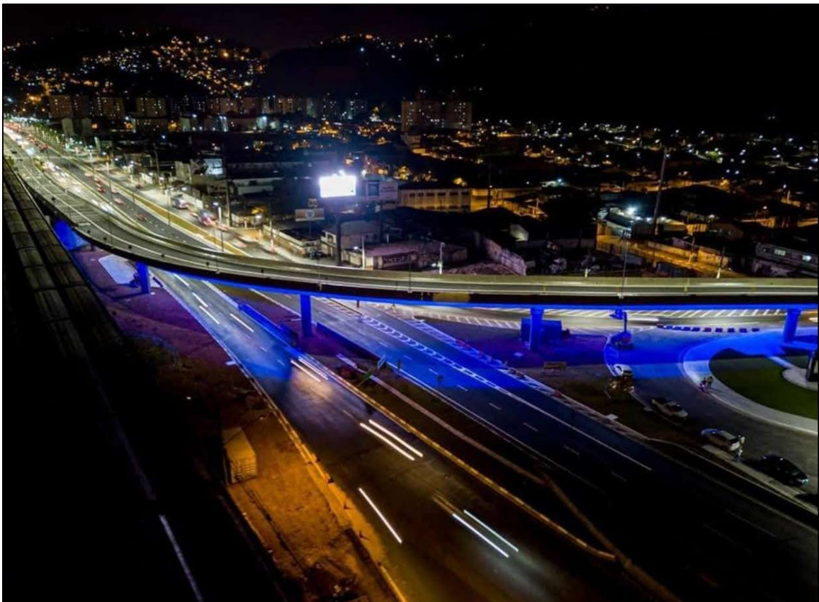
Viaduto em Curva da Nossa Senhora de Fátima, Santos - SP, 2020.
